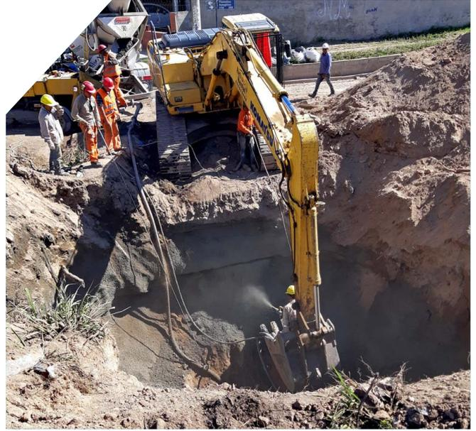
Estabilización de taludes con gunitado
