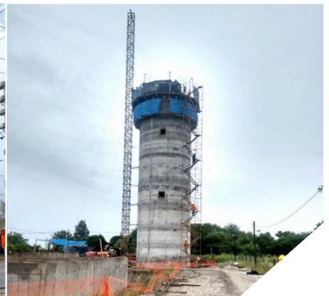
Ejecución de tanques elevados mediante tecnica de deslizados
