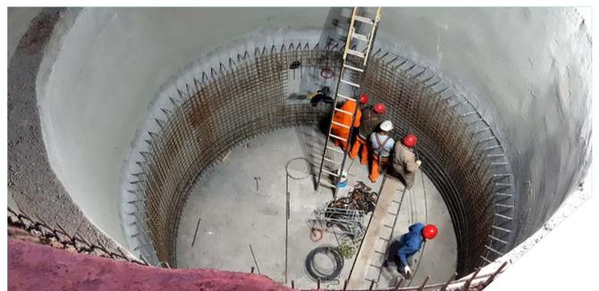
Pozo de ataque gunitado para tunelera jacking
