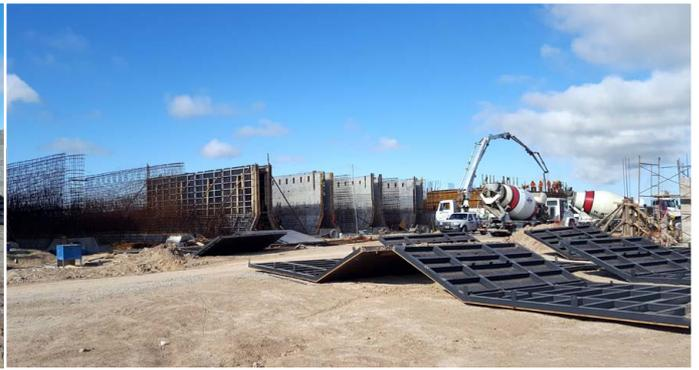
Ejecución de los sedimentadores de la futura planta potabilizadora
