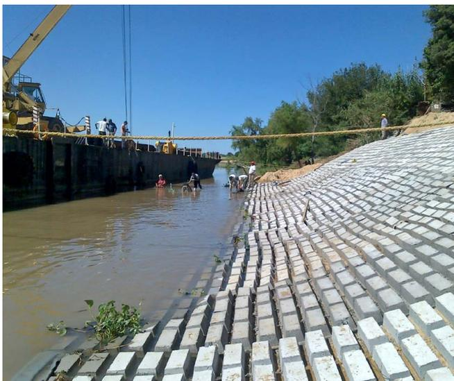
Protección de relleno de refulado con manta flexible. Colocación de mantas Flexibles.
