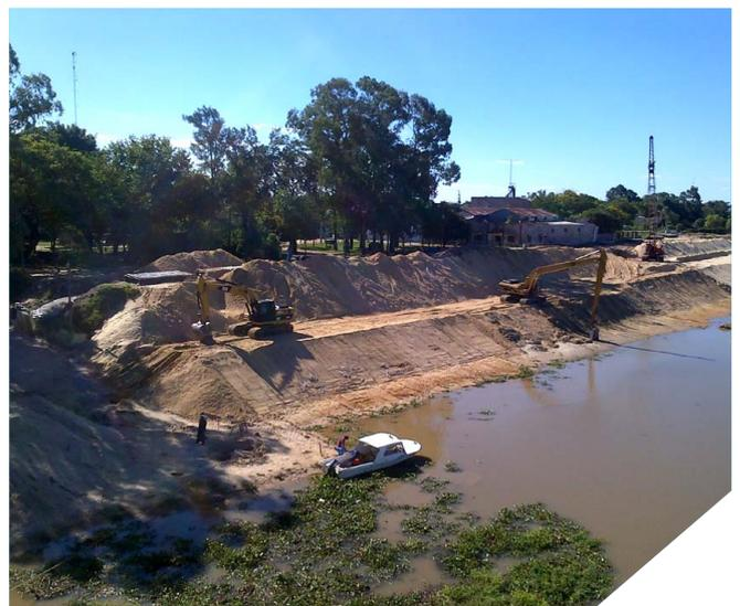
Protección de relleno de Refulado con manta Flexible - Ejecución de Taludes.
